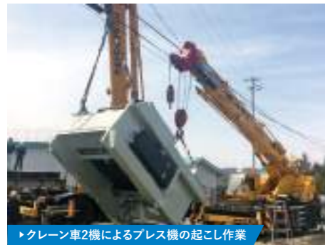
▶クレーン車2機によるプレス機の起こし作業
