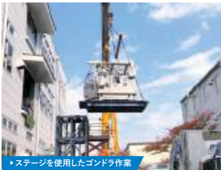
▶ステージを使用したゴンドラ作業
