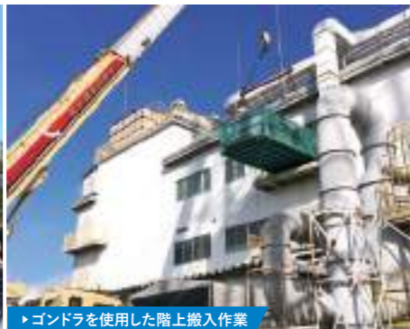
▶ゴンドラを使用した階上搬入作業
