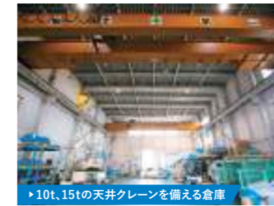
▶10t、15tの天井クレーンを備える倉庫
