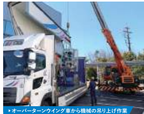
▶オーバーターンウイング車から機械の吊り上げ作業
