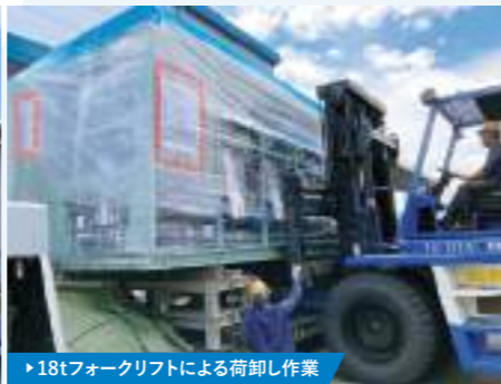
▶18tフォークリフトによる荷卸し作業
