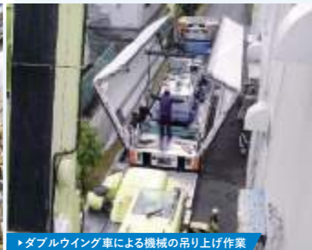
▶ダブルウイング車による機械の吊り上げ作業
